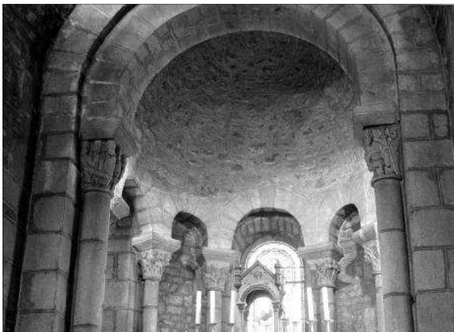
Vue sur l'abside de Riom et sa voûte en cul-de-four.
