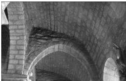
Ci-dessous : voûte en quart de cercle des collatéraux et coupole sur trompes.
