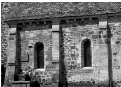
Les murs et les fenêtres des bas-côtés, refaits au XIX e siècle.
